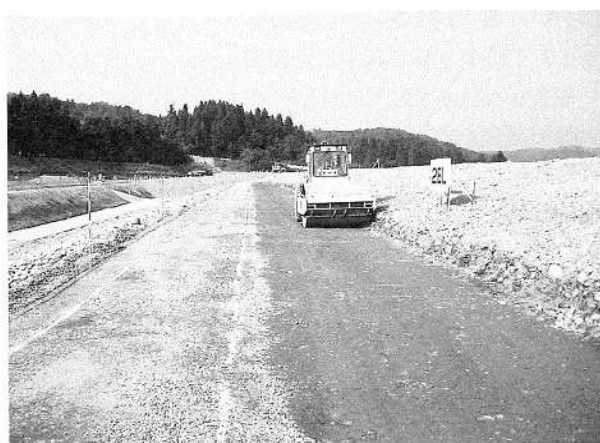
写真一七 上流さや土転圧状況 (山本調整池)
