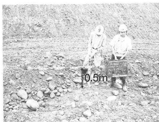
復旧時（平成 17 年）
