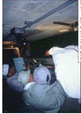
浸透量計(三角堰)の確認
