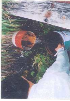
調査方法: 簡便な漏水量計測例 (20L缶を用いて、一定時間内の漏水量を計測)
