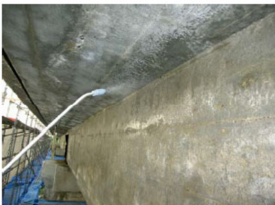
写真9.3-4 表面含浸材塗布（噴霧）
