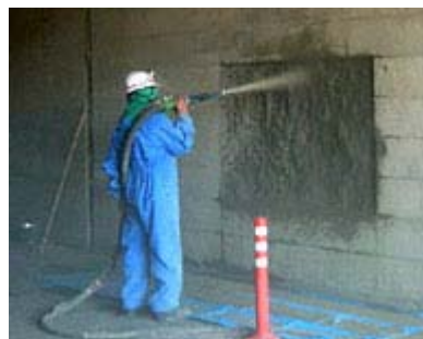
写真 7.1.2-2 吹付け工法
