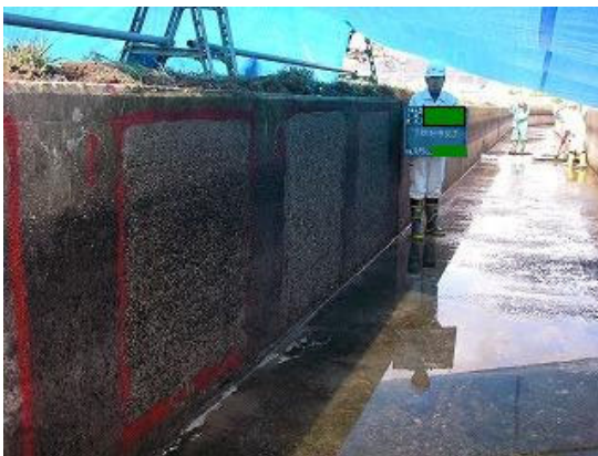
写真 4. 3. 2-3 試験状況(下地処理完了)
