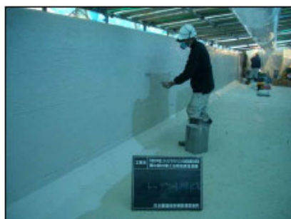
写真 5.2.1-1 有機系被覆工法 （塗り付け型）施工状況
