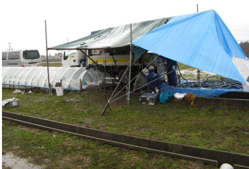
写真 5. 2. 4-1 ビニールシート養生設置
