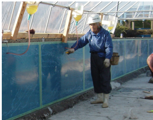
写真 5.3.2.2-4 樹脂注入工
