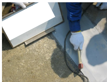
写真 8.3.2-8 シート取付け アンカー打設
