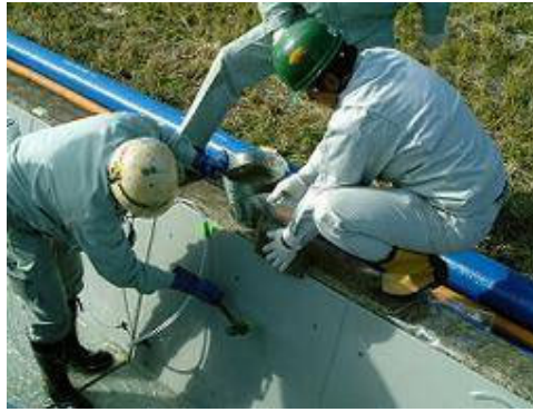
写真 5.3.3.2-4 グラウト注入工（ポンプ圧入の場合）
