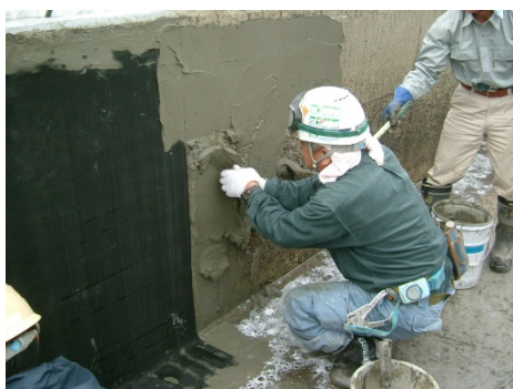
写真 5. 4. 3-6 ポリマーセメントの塗布状況
