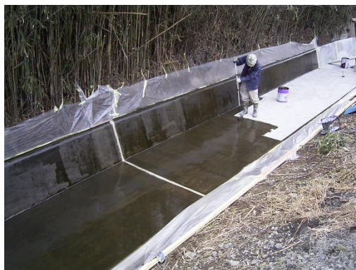
写真 5. 2. 4-4 プライマー工
