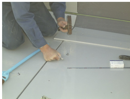
写真 5. 3. 3. 2-2 アンカー打設によるパネル取付工
