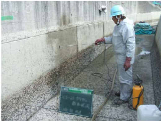
写真9.3-1 表面含浸材塗布（噴霧）
