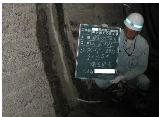
写真 5.1.3-3 ひび割れからの湧水の導水処理
