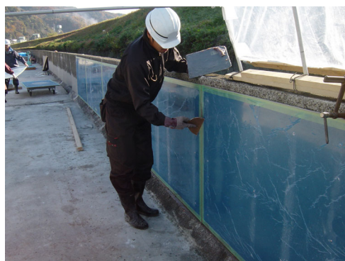
写真 5.3.2.2-3 パネル目地工
