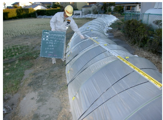
写真 4.3.1-2 養生工の設置
