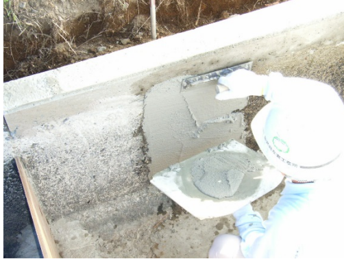
写真 5. 2. 4-3 不陸調整工
