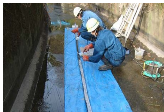
写真 8. 3. 2-13 接着材の塗布状況(2)
