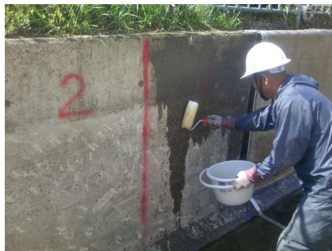
写真 5.3.2.2-1 プライマー工
