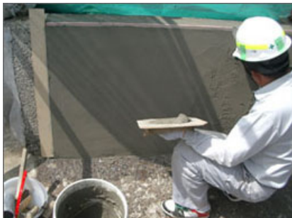
写真 5.1.1-1 無機系被覆工法（左官工法）施工状況
