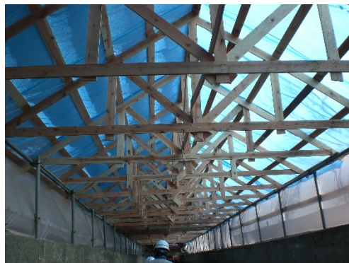
写真 5. 2. 4-2 ビニールシート養生設置内部
