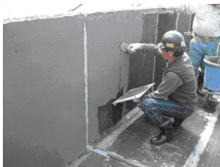
写真 5. 4. 3-8 保護モルタルの左官仕上げ状況
