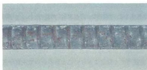
腐食度区分：A 又は I
