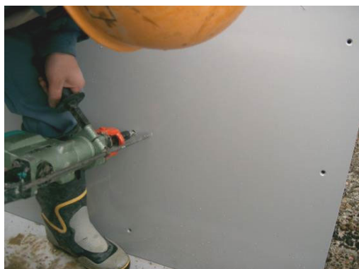
写真 5. 3. 3. 2-1 アンカー打設用下穴削孔
