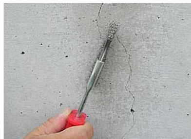
写真 6.3.1-1 ひび割れ部の清掃の例
