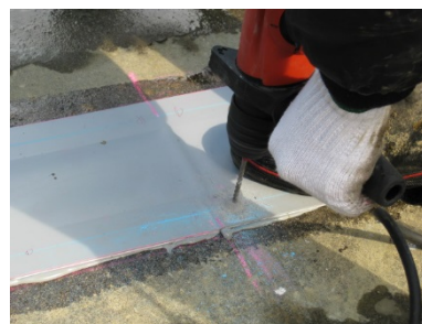
写真 8.3.2-7 シート取付け アンカー削孔
