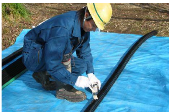
写真 8. 3. 2-12 接着材の塗布状況(1)
