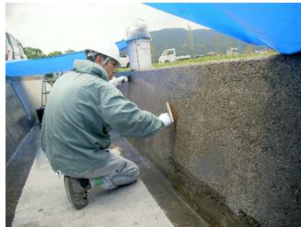
写真 5. 4. 3-2 ヘラによるプライマーの塗布状況
