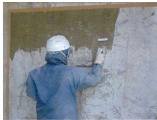
写真9.3-5 表面含浸材塗布（ローラー）
