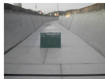
写真 3.3.2-1 側壁：無機系被覆工 底版：パネル工法の施工例
