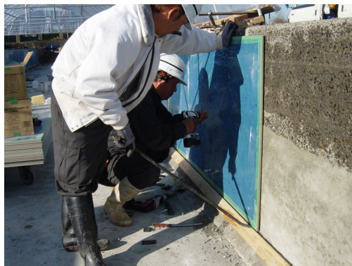
写真 5.3.2.2-2 パネル設置工
