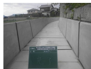
写真 3.3.2-2 側壁：無機系被覆工 底版：パネル工法の施工例
