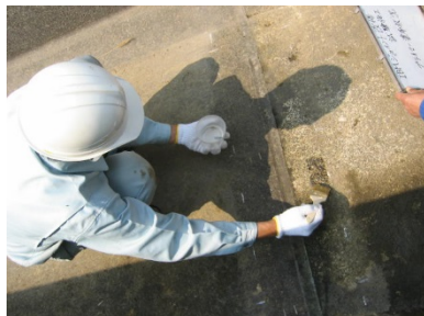
写真 8.3.2-5 プライマー塗布
