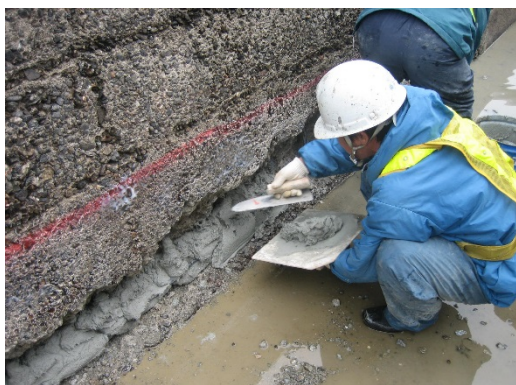
写真 5.1.3-1 断面修復材の充填
