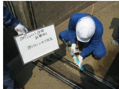
写真 8.3.2-6 シーリング材打設
