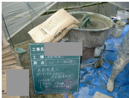
写真 5. 1. 3-5 ポリマーセメント モルタルの練混ぜ
