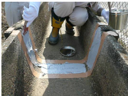
写真 8.3.2-1 接着材の塗布
