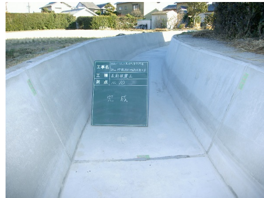
写真 5.1.3-9 表面被覆完了
