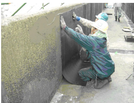
写真 5. 4. 3-7 シートの貼付け状況
