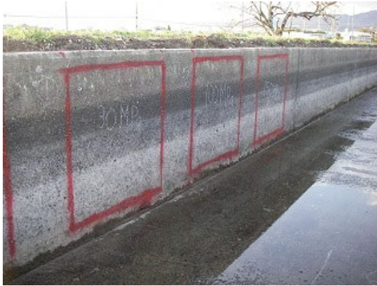
写真 4. 3. 2-1 現場試験施工前
