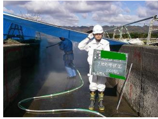
写真 4. 3. 2-2 試験状況(下地処理)
