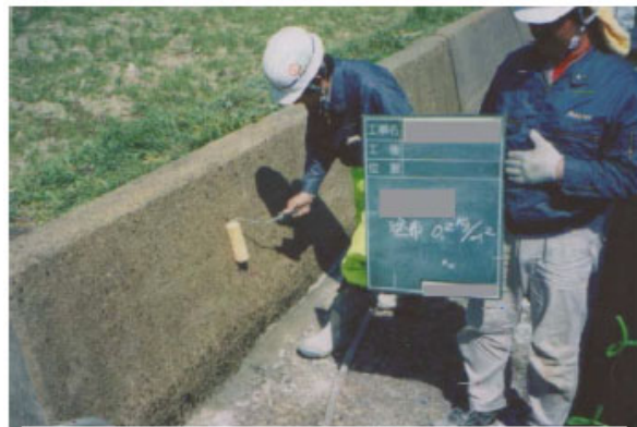
写真9.3-2 表面含浸材塗布（ローラー）
