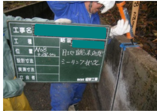
写真 8. 3. 2-15 端部処理
