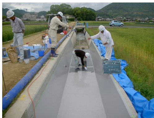
写真 5. 4. 3-5 トップコート塗布状況
