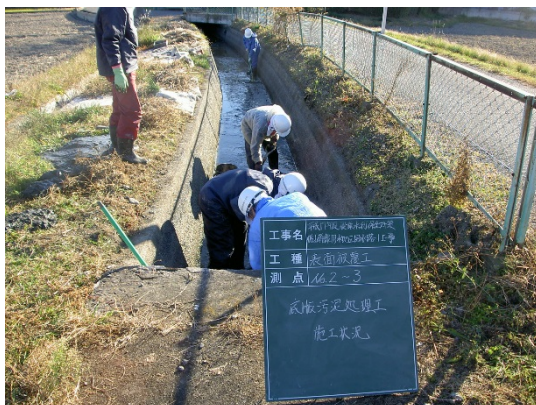
写真 4.3.1-1 水路底版の清掃
