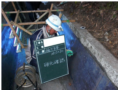
写真 5. 4. 3-4 硬化確認状況
