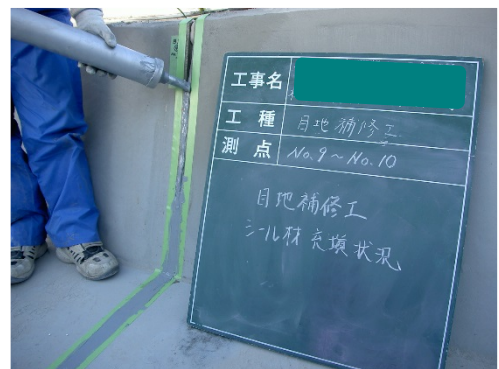
写真 8.3.1-1 シーリング材の充填
