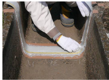
写真 8.3.2-2 シートの貼り付け
