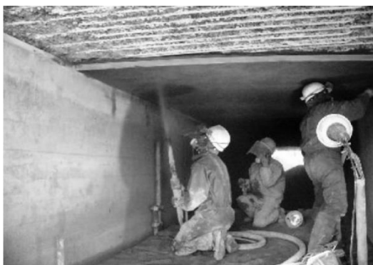
写真 7.3-6 吹付け工法の例
