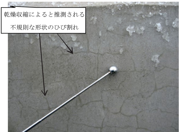
写真 5.1.4.1-2 乾燥収縮ひび割れ 4)
