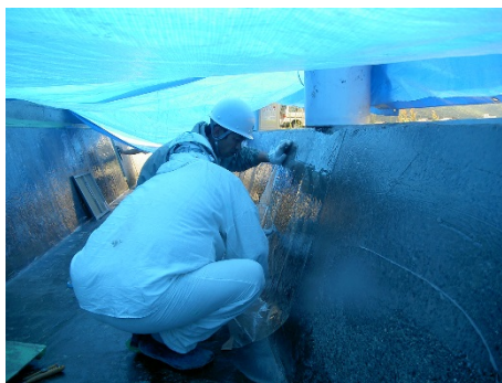
写真 5. 4. 3-3 脱泡作業状況
