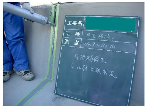
写真 8.3.1-1 シーリング材の充填
