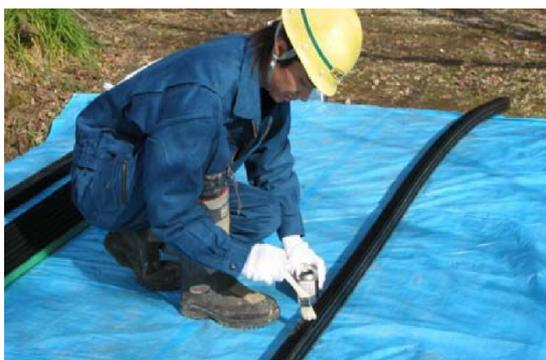
写真 8. 3. 2-12 接着材の塗布状況(1)
