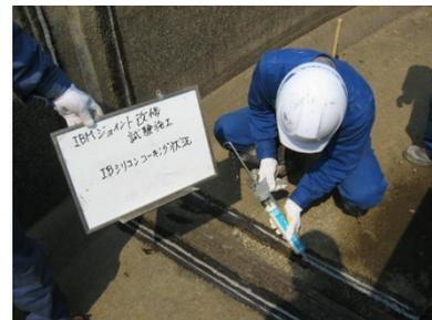
写真 8.3.2-6 シーリング材打設
