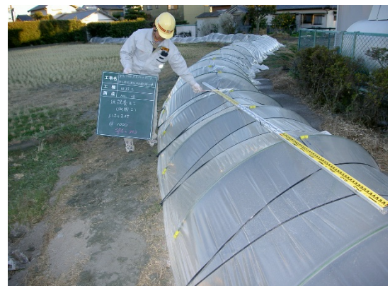
写真 4.3.1-2 養生工の設置
