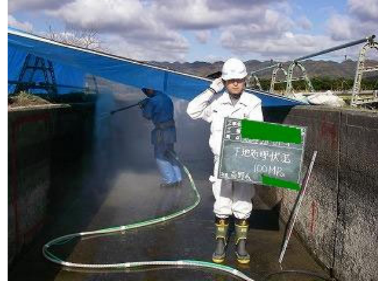
写真 4. 3. 2-2 試験状況(下地処理)
