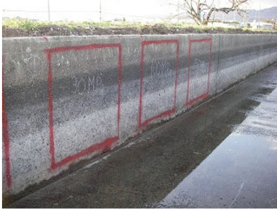
写真 4. 3. 2-1 現場試験施工前
