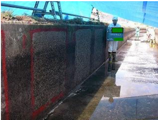
写真 4. 3. 2-3 試験状況(下地処理完了)
