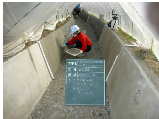
写真 5. 1. 3-6 左官コテによる施工
