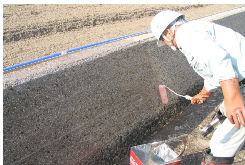
写真 5.1.3-4 プライマー塗布
