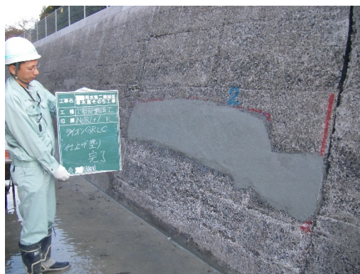
写真 5.1.3-2 断面修復終了後
