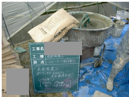
写真 5. 1. 3-5 ポリマーセメント モルタルの練混ぜ
