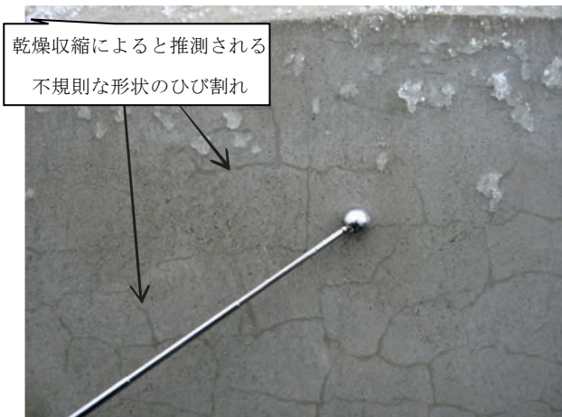
写真 5.1.4.1-2 乾燥収縮ひび割れ 4)
