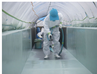
写真 5.2.1-2 有機系被覆工法 （吹付け型）施工状況
