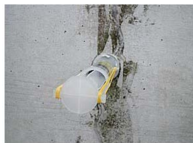
写真 6.3.1-3 注入用器具による注入例
