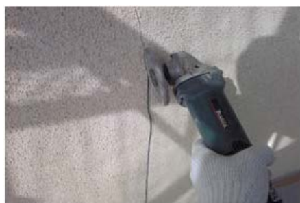
写真 6.3.2-1 U字カットの例
