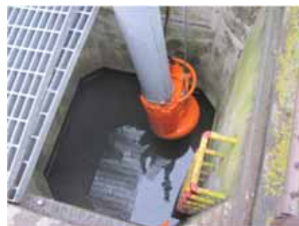
写真-3.2.5 ポンプ排水（水替え工）
