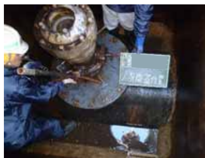
写真-3.2.4 進入部の確認
