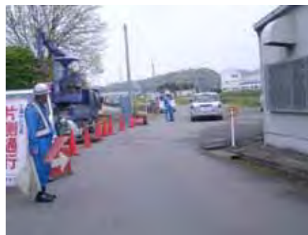
写真-3.2.3 安全施設・交通誘導員の配置
