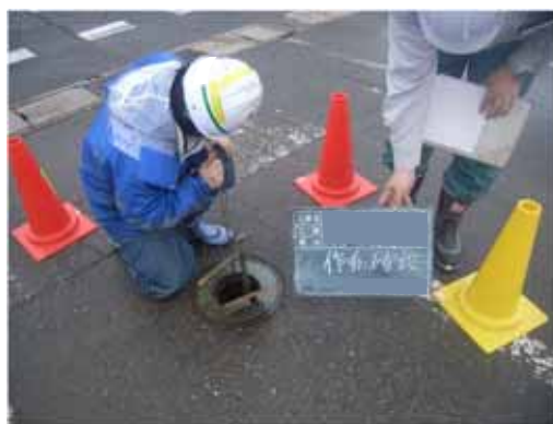
写真-3.2.2 音聴調査の実施（制水弁部）
