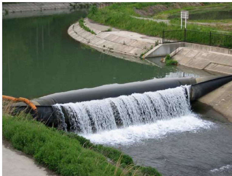
①水没状態にある固定金具や袋体外面の確認等
