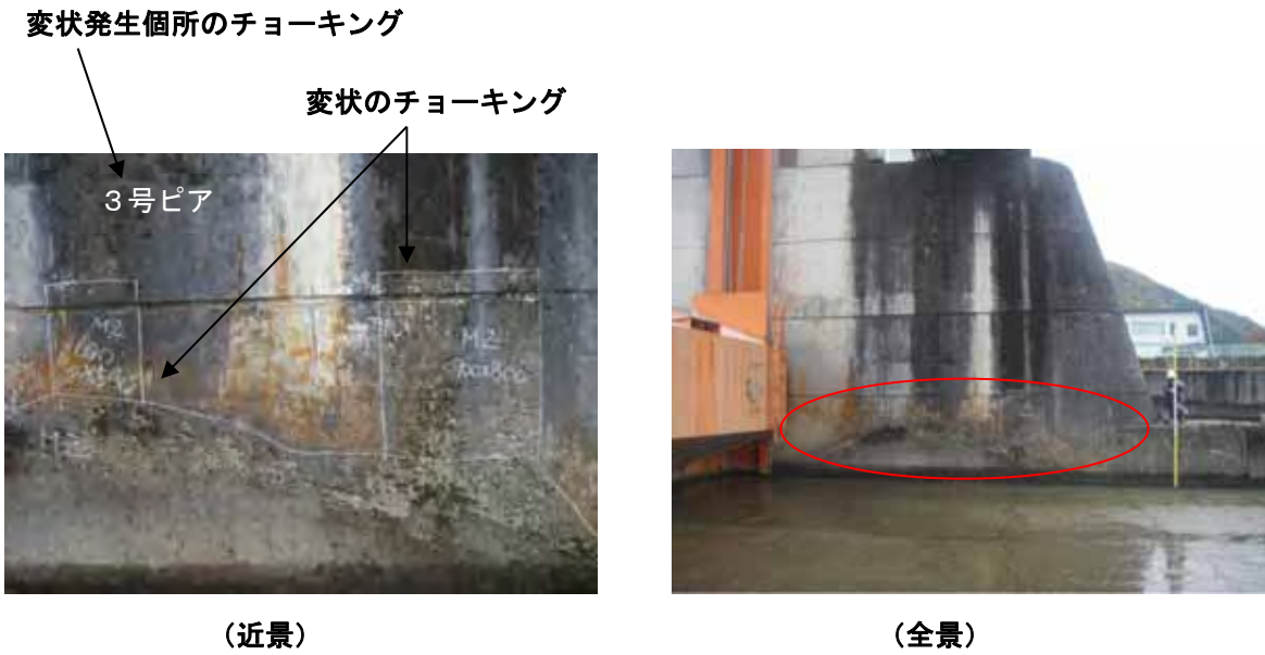
写真-4.2.3 写真撮影例
