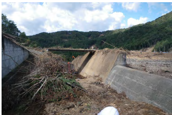
[洪水吐越流部付近]
