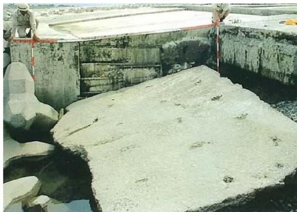
**【図4-6 底面の空洞化（土砂流出）によるエプロンの陥没】**
