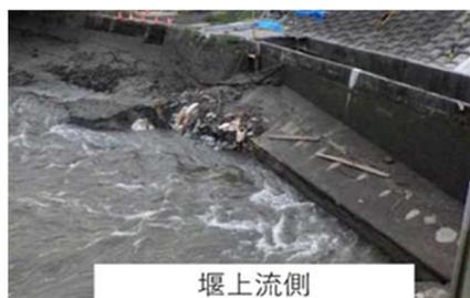
【写真1】パイピングによる漏水状況
