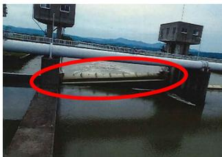
巻上げ機の故障によるゲート片吊り
