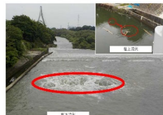
浸透破壊によるパイピング
