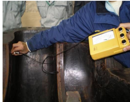
図 5.2.27 塗膜の測定（例）
