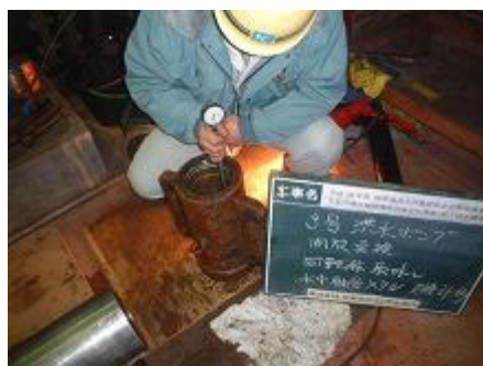
図 5.2.44 スリーブ軸受内径計測 (例)
