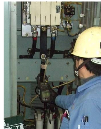
クランプメータによる電流測定
