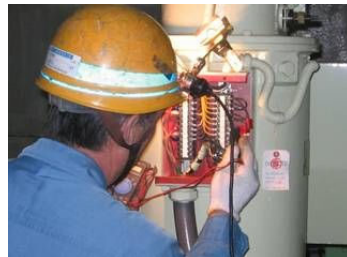
テスターによる電圧測定
