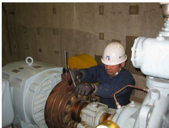
図 5.2.17 軸芯通り測定方法 (例)
