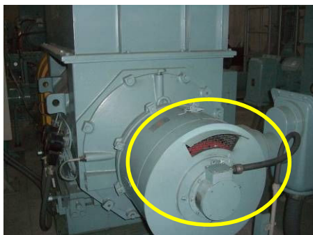
巻線形電動機のブラシ・スリップリング部側の写真
