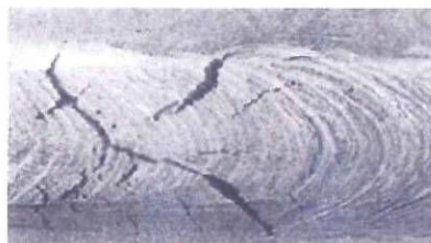
図 5. 2. 52 現像処理により現れた溶接部の欠陥(例)
