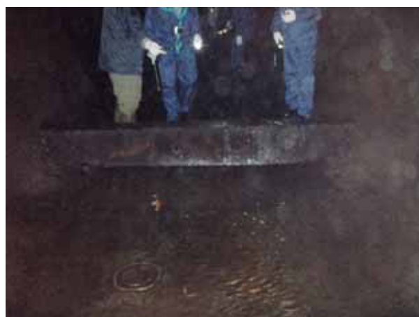
図-2.4.3 導水路途中にある堰
