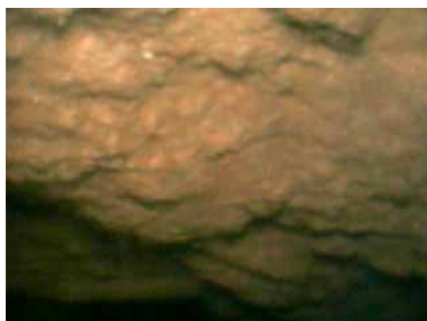
図-2.4.5 広角カメラを用いた覆工背面空洞状況の確認
