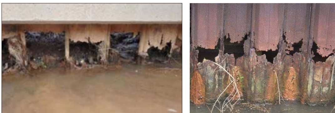
写真 2.2-1 断面欠損（例）
