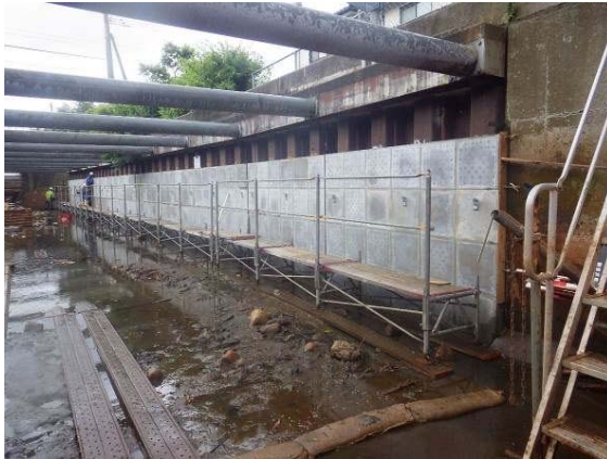
写真 5.2-14 パネルの組立て (例)
