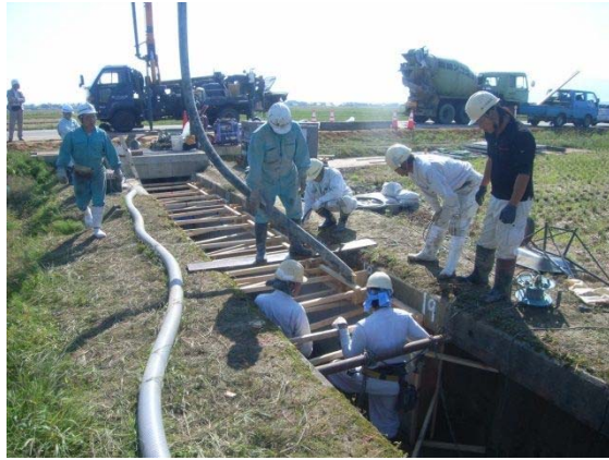
写真 5.2-18 上部のコンクリート投入口からの打設（例）
