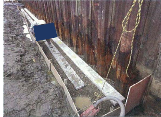
写真 5.2-13 均しコンクリート工（例）
