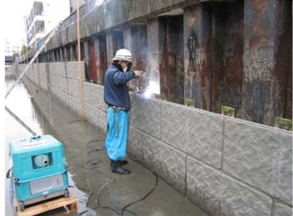
写真 5.2-15 接続金具の溶接 (例)
