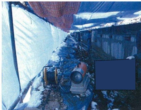
写真 5.2-20 ジェットヒーターによる養生工（例）
