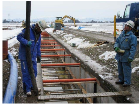
写真 5.2-19 笠コンクリート削孔部からの打設（例）
