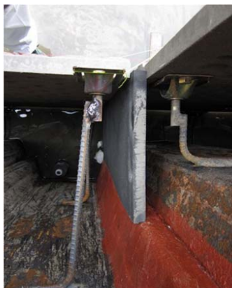
写真 5.2-17 伸縮目地の設置状況
