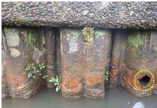
写真 1.2-2 開孔がある鋼矢板の例
