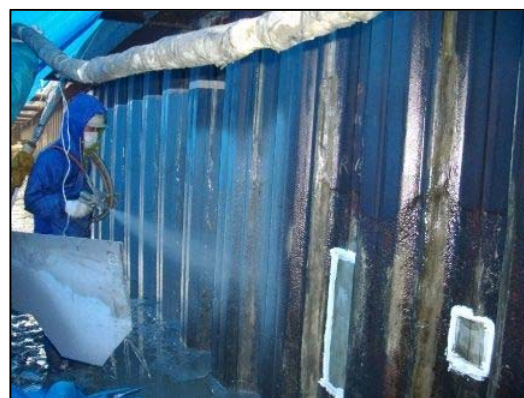
写真 3.2-2 有機系被覆工法 (吹付け型) 施工状況
