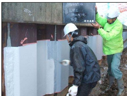
写真 3.2-1 有機系被覆工法 (塗付け型) 施工状況
