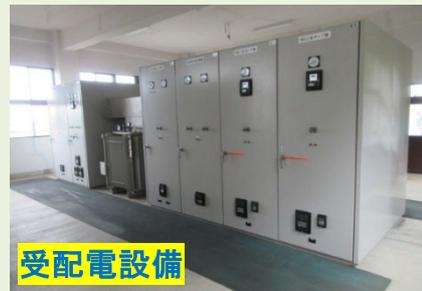
図 2-2 農業用ポンプ場の電気設備(例)
