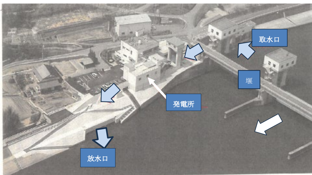
写真 参2-1 新田原井堰発電所の全景（発電所は右岸）
