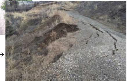
盛土のり面に部分的な崩壊や、のり肩に大規模な亀裂・明瞭な段差が生じる等、崩壊し始めている（崩れかけている）。
