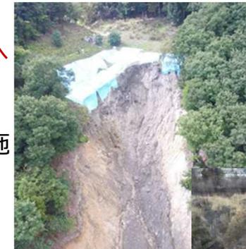
←盛土のり面に崩壊が発生し、盛土頭部や中腹において土砂が不安定化している。二次災害の発生や被害の拡大のおそれがある危険な状態。
