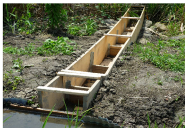
水田魚道の設置
