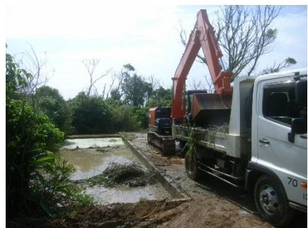
沈砂池の泥上げの様子
