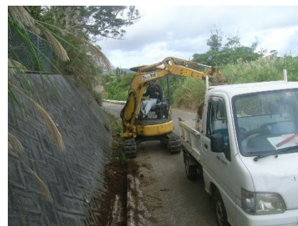
側溝の泥上げ
