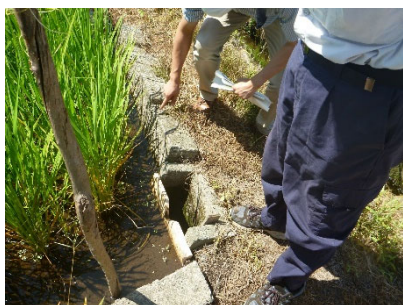
自作の排水調整板設置状況
