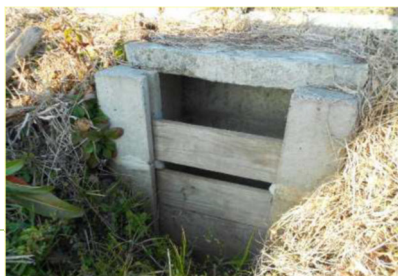
排水口への堰板の設置
