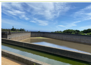
水位調整後のカヤため池 (水深 1～2 m)
