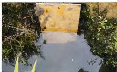
止水板による止水状況
