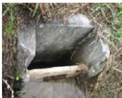
堰板による田んぼダムの取組
