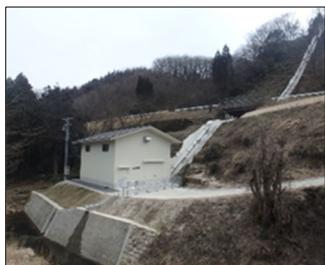
小水力発電所
