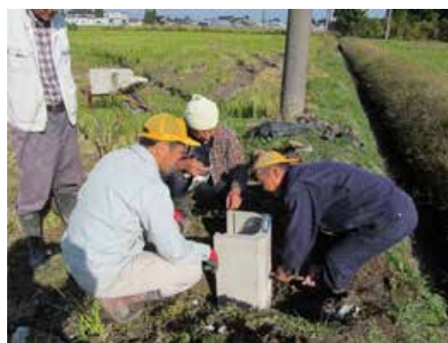
排水槽の交換設置
