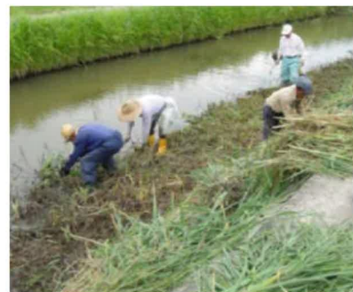
浄化水路の草刈り
