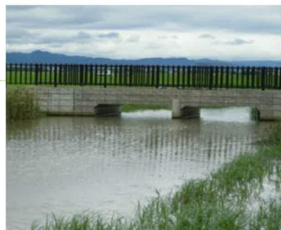
浄化型幹線排水路
