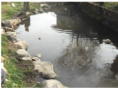
農業用水路への通水状況
