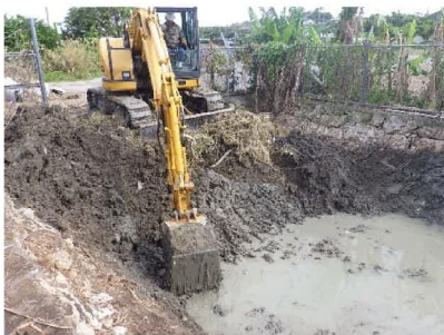
沈砂池の泥上げ
