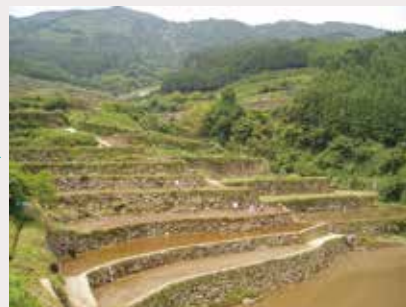
復旧後の棚田
