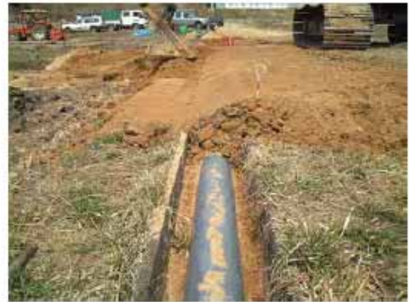
現況水路にパイプを敷設
