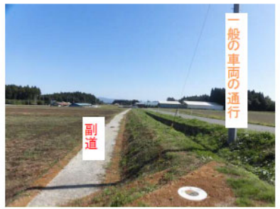
副道の設置により、一般車両の通行を妨げることなく安全に作業可能。また、高低差が少ないため、畝搬出作業時のあゆみ板が不要。
