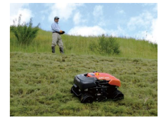
無線遠隔草刈機による除草作業
