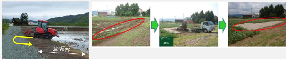
農業機械走行時の安定性の低下を防ぐため、可能な限り緩いスロープとし、排水性を考慮した法尻部対策 (砂敷設等) の検討が必要です。
