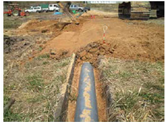
現況水路にパイプを敷設
