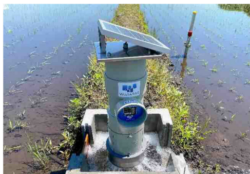
畦畔に設置した自動給排水栓
