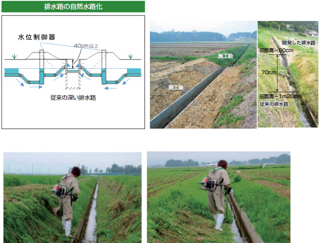
図 小排水路での草刈り作業比較(左:従来施工圃場 右:FOEAS 施工圃場)
