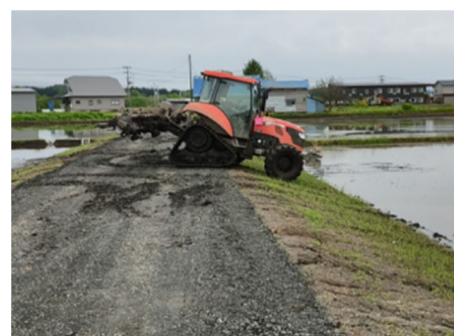
施工後のターン農道
