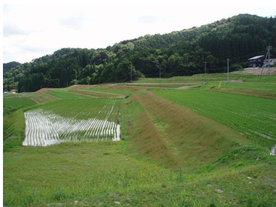
緩勾配法面に芝の植生を実施した法面
