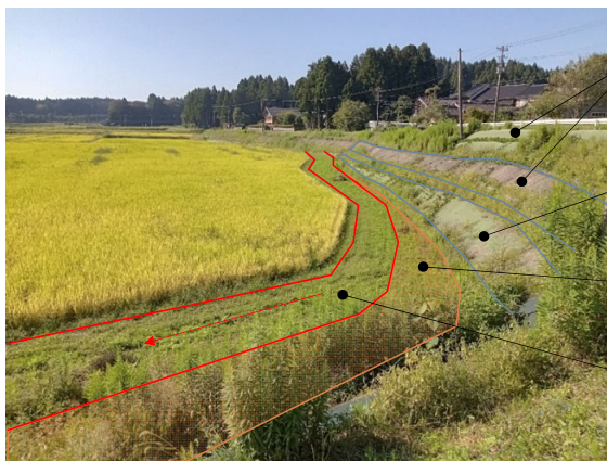
コンクリートマット (除草不要、市道改良工事にて設置) 防草シート (除草不要、中山間地域等直接支払を活用した取組みにて設置) 機械除草範囲(排水路土羽部分) 溝畔の拡幅(3.0m)
