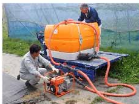
使用する薬液タンクおよびポンプ
