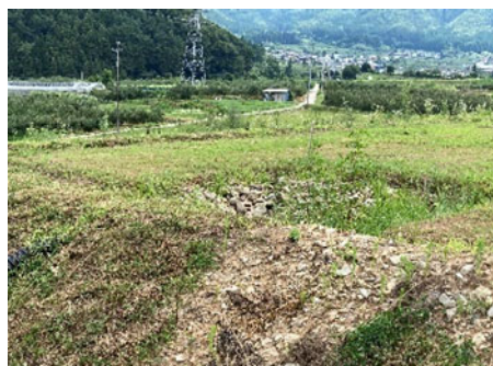
明渠と掘込式釜場
