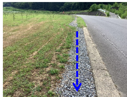
碎石と暗渠埋設
