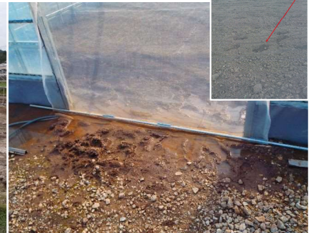
ハウス入口の排水状況
