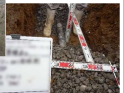
暗渠排水施工状況写真
