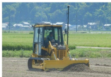
ICT ブルドーザによる作業状況
