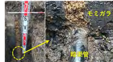
本工法による暗渠再生状況
