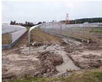
ハウス建設中における敷地内の排水状況
