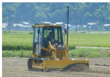
ICT ブルドーザによる作業状況
