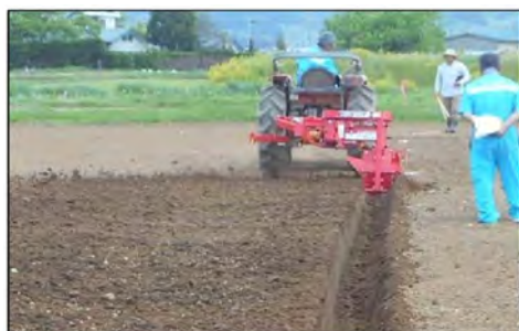
溝掘機による明渠の施工 2)
