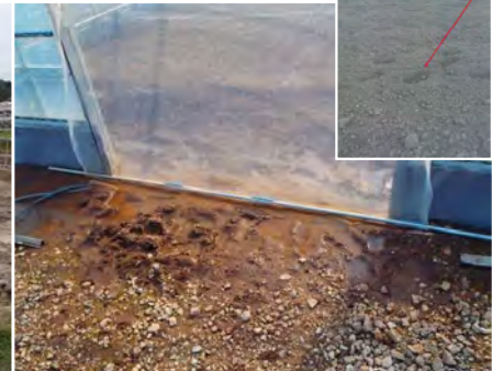
ハウス入口の排水状況
