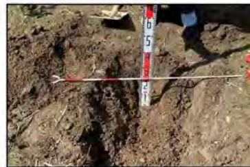
幹線パイプ上部の疎水材
