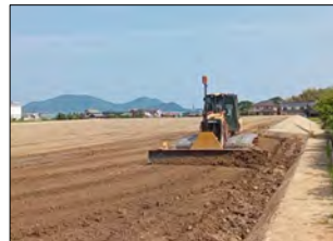
超湿地ブルドーザによる表土戻し 20)
