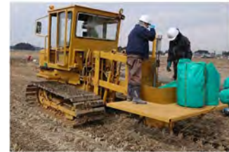
ドレーン・リフレッシュー工法による施工状況
