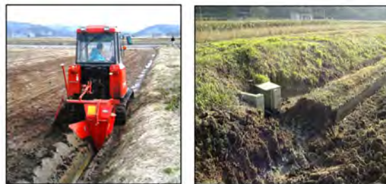
スクリーオーガー型 溝掘機による額縁明渠 の施工 6)
