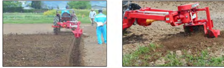
溝掘機による明渠の施工状況 18)
