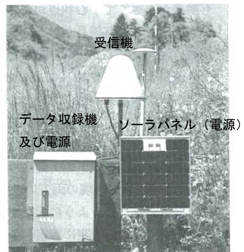
図-2.9.13 GNSS受信装置の設置状況の例
