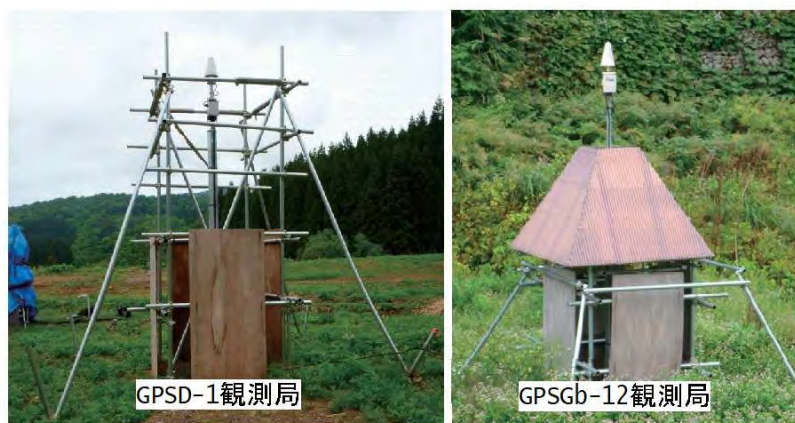
図-4.8.3 豪雪地域におけるGNSS観測局の設置例（庄内あさひ地区（山形県））
